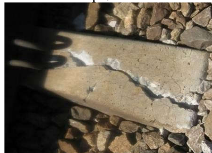
Рис. 4. Основні дефекти (пошкодження) шпал
