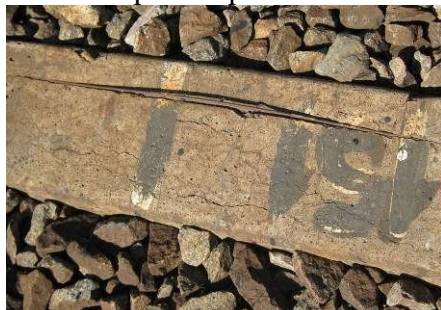
Рис. 4. Основні дефекти (пошкодження) шпал
