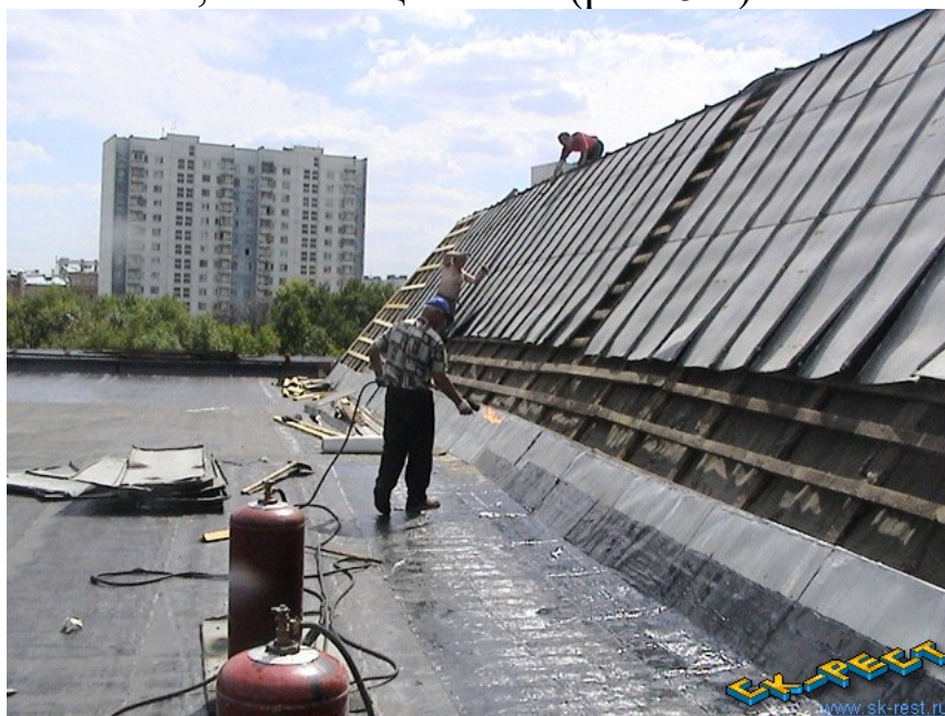
Рис. 5.1. Влаштування покрівлі
