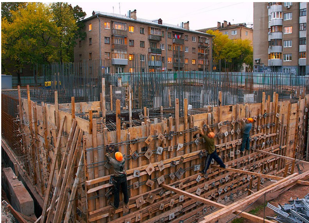
Рис. 5.11. Встановлення опалубки для бетонування
