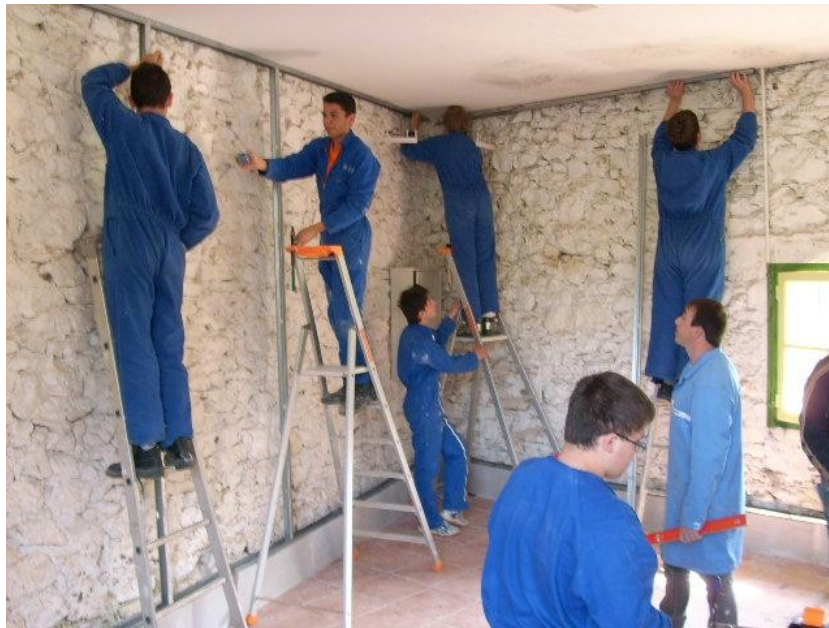
Рис. 5.3. Опоряджувальні роботи в кімнаті будівлі
