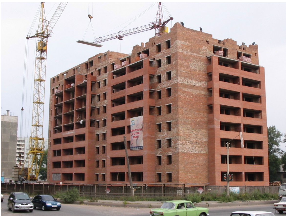
Рис. 5.8. Зведення багатоповерхового цегляного будівлі
