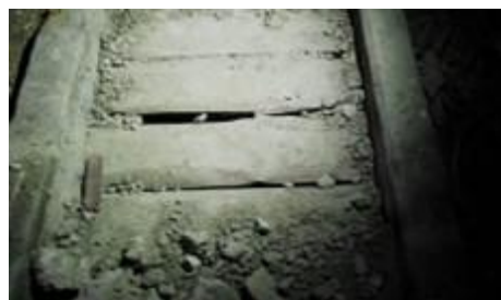
Рис. 2. Розкриття горищного перекриття
