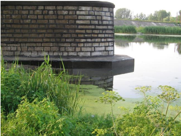
Рис. 8. Сталобетонний пояс мостової опори ( а ) і полімеркомпозиційний прокладний шар БМП ( б ) як заходи із захисту від впливу надлишкових електричних зарядів після 11 – 12 років експлуатації
