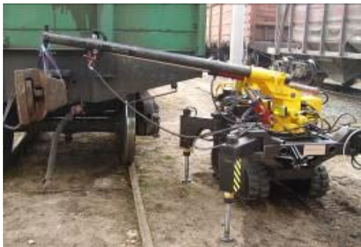
Рис. 2.8. Установка УПЛМ-1 "Катюша" при заміні автозчепного обладнання
