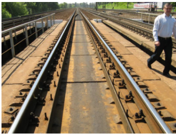
Рис. 1. Безбаластне мостове полотно із залізобетонних плит: а – загальний вигляд; б – конструкція: 1 – плита БМП; 2 – контруктник; 3 – рейка; 4 – верхня полка подовжньої (головної) балки прогонової будови; 5 – армована гумова стрічка прокладного шару; 6 – дерев'яна дошка прокладного шару; 7 – високоміцна шпилька; 8 – отвір в плиті для високоміцної шпильки
