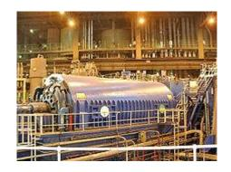
Die Kombination des Turbogenerators und der Turbine wird als Turbosatz bezeichnet.
