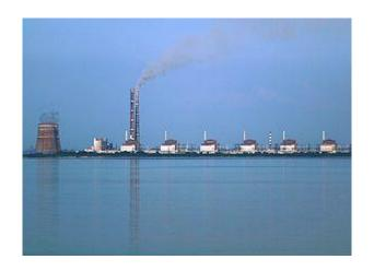
Die thermische Leistung von "Saporischschja" beträgt sogar knapp 20 Gigawatt. Das benötigte Kühlwasser wird dem Fluss Dnepr entnommen, an dessen Ufer die Kraftwerksanlage gebaut wurde. Der Fluss wurde an dieser Stelle extra verbreitert, damit er besser die Wärmemengen aufnehmen und abführen kann. großen Die Leichtwasserreaktoren haben eine elektrische Gesamtleistung von 5.700 MW netto und bilden somit zusammengerechnet leistungsstärkste Kernkraftwerksanlage Europas.
