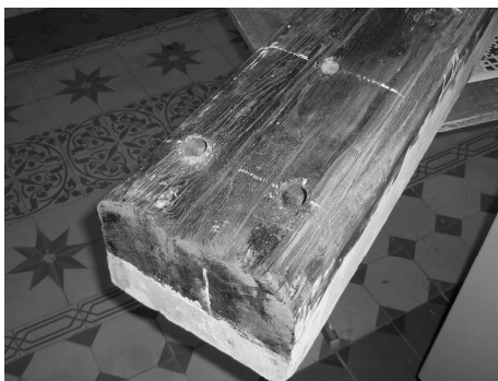
Рис.2 – Шпала с просверленными отверстиями для заливки раствора
