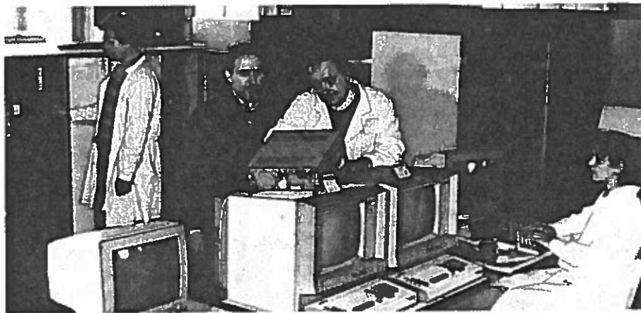
Машинный зал АСУ "Экспресс-2" информационно-вычислительного центра Юго-Западной ж.д. Работает смена в составе вед.инж. А.И.Бабина, ст.электромеханика А.А.Паламарчука, нач.отдела электроники В.А.Шейковского и инж. Н.А.Шевченко.
