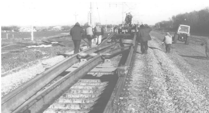
Рис. 2.18. Укладання зварних плітей безпосередньо з рейкового поїзда
