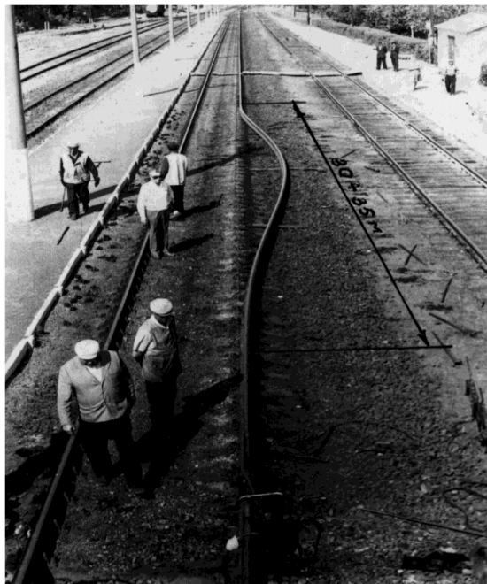
Рис. 3.3. Попередній вигин частини рейкової пліти при проведенні зварювальних робіт
