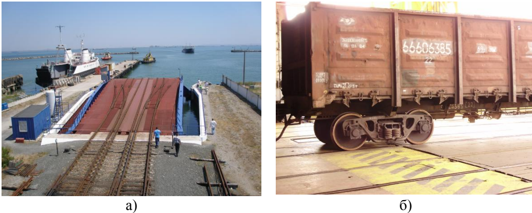
Рис. 1. Перехідний міст для завантаження/вивантаження вагонів на/з залізничного порому а) на станції «Крим»; б) на станції «Іллічівськ-Поромна»
