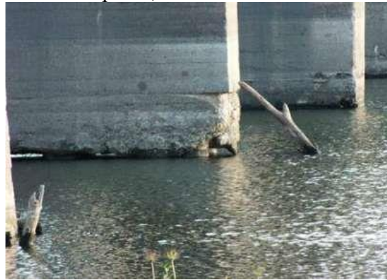
Рис.6. Вимивання нижньої частини опор
