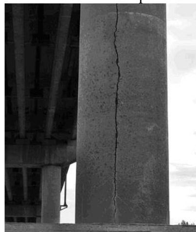
Рис.7. Фрагмент опори моста через річку
