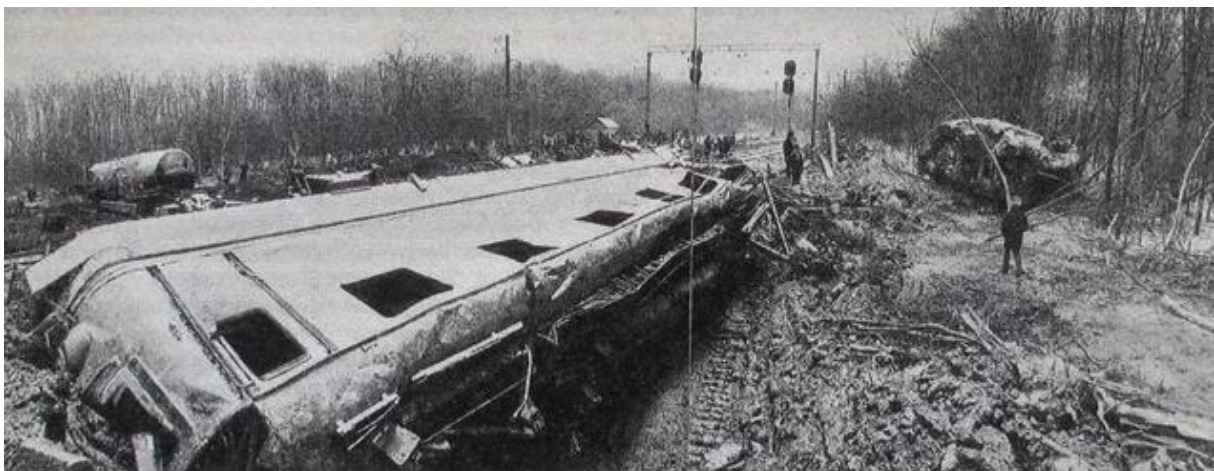
Рисунок 2 – Наслідки транспортної події на станції Єльникове
