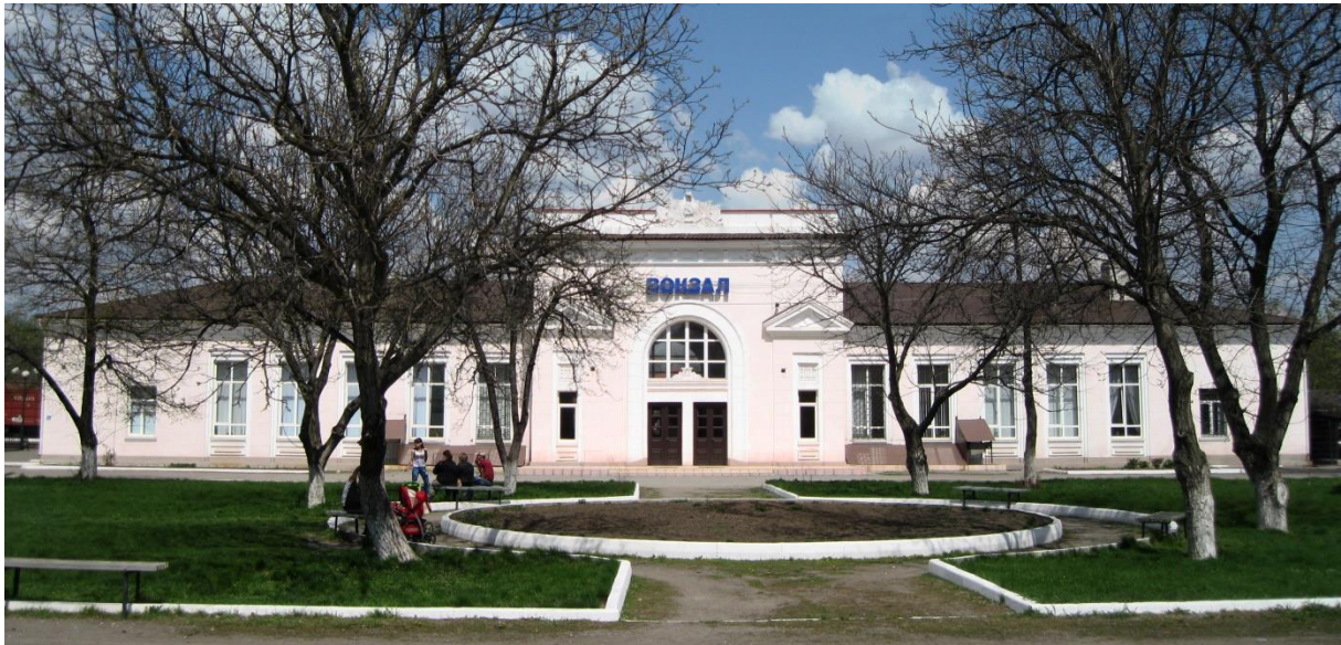
Рисунок 11 – Залізничний вокзал станції Користівка
